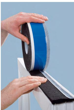
Mousse imprégnée d'étanchéité multifonctionnelle brevetée ISO-BLOCO ONE, performante sur le marché depuis 2008 - © ISO-Chemie
