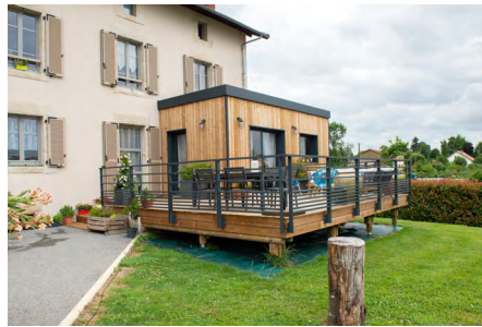
Extension de maison à Limoges
